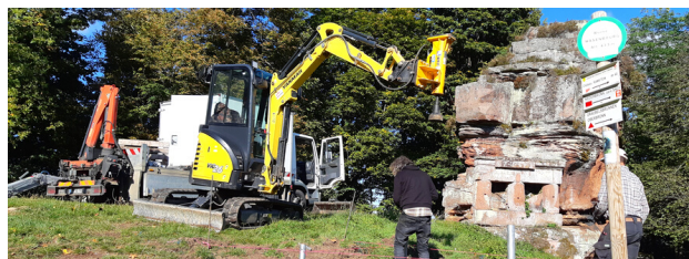
Mise en place d'un abri à la Wasenbourg
