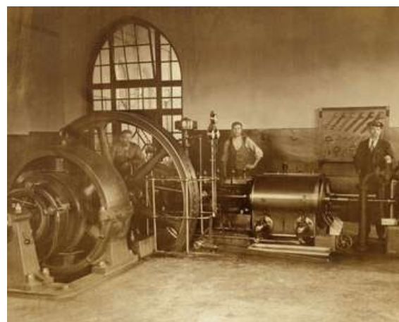
La salle des machines de l'usine d'électricité en 1900
