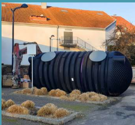
Moulin 9 : rénovation d'une partie de la toiture et installation d'une cuve de rétention des eaux pluviales
